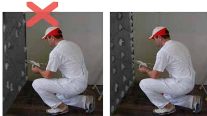
Figura 88: Aplicación de la pasta de agarre.
