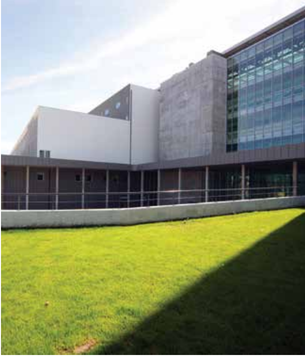
Nuevo Hospital de Braga Braga, Portugal
